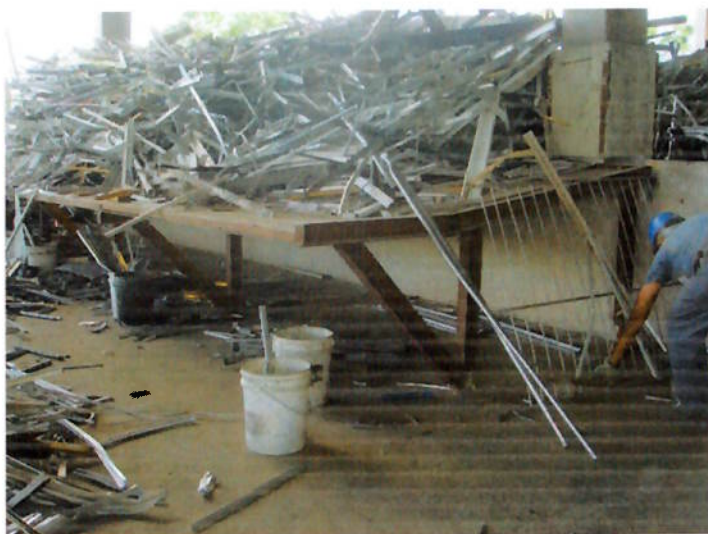
Figura 26 Bancada piloto em estrutura metálica
