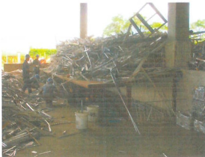
Figura 27 Bancada piloto em estrutura metálica
